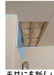
天井にも新しい断熱材
