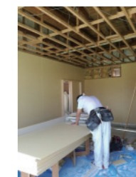
壁の下地施工
