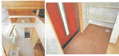
天井なく勾配天井(左)と床面排気口(右) ▷小堀建設(株)=笠岡市二番町5、フリーダイヤル0120・194・623、電0865・63・5001、 https://koboken.co.jp/ (小堀建設)、 https://e-mutumi.com/ (睦みの工房)。「健康経営優良法人」、笠岡市認定「健康づくり実践事業所」・「子育て応援企業」は毎年更新
